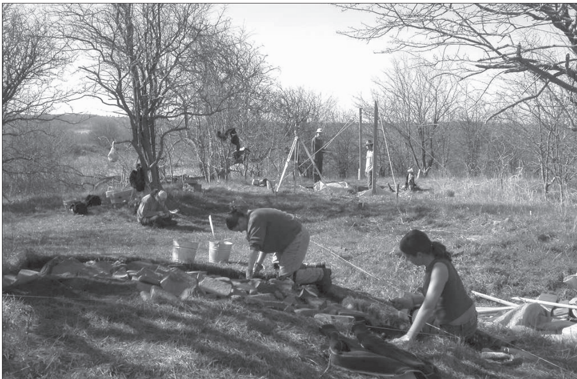
Chantier école de l'Université Sainte-Anne en 2005. Les étudiants dégagent les vestiges de deux grandes maisons acadiennes dont l'occupation remonte aux premières décennies du 18 e siècle.
